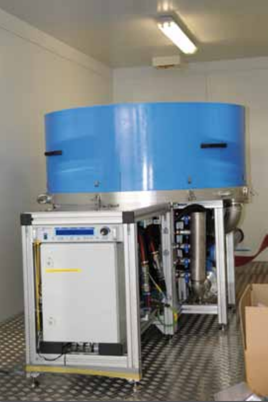
Der fertiggestellte Demonstrator des «Hightech-Mühlrades» im Thermalbad Zurzach.
